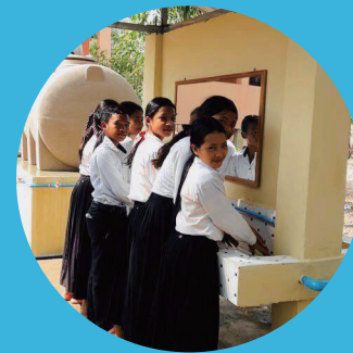
CAMBODIA 水衛生環境改善プロジェクト サンプル地区の小学校にて洗い場を建設
